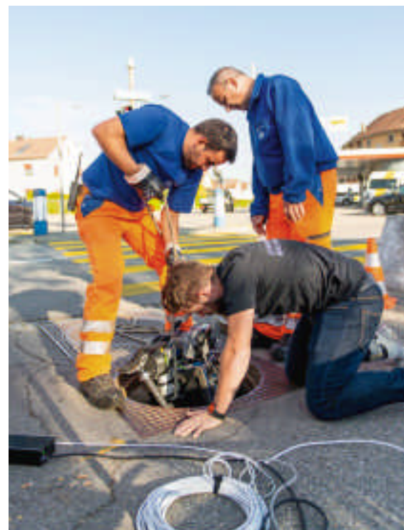
Vorsichtig wird die Hightechmaschine durch den engen Kanalisationsschacht bugsiert.
